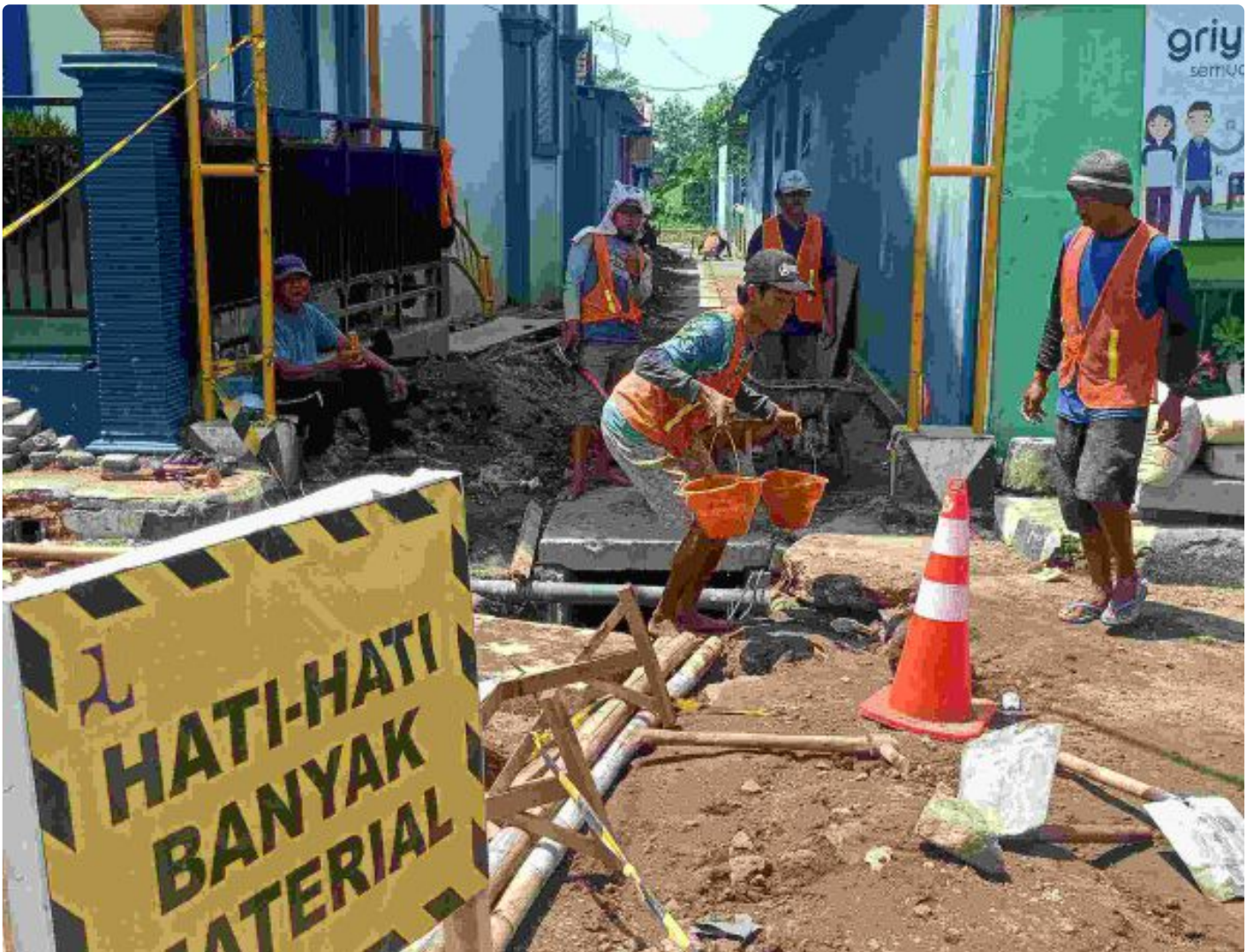
Pekerjaan pembangunan drainase di Banaran terus dikebut. (Foto:prijo atmodjo)
